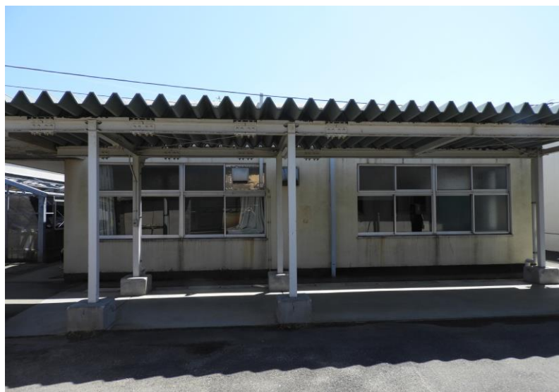
R3年度解体箇所(旧作業棟北側)
