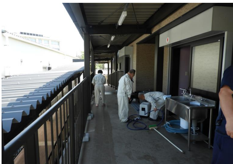
新作業棟2階（陶芸班前トイレ前通路）
