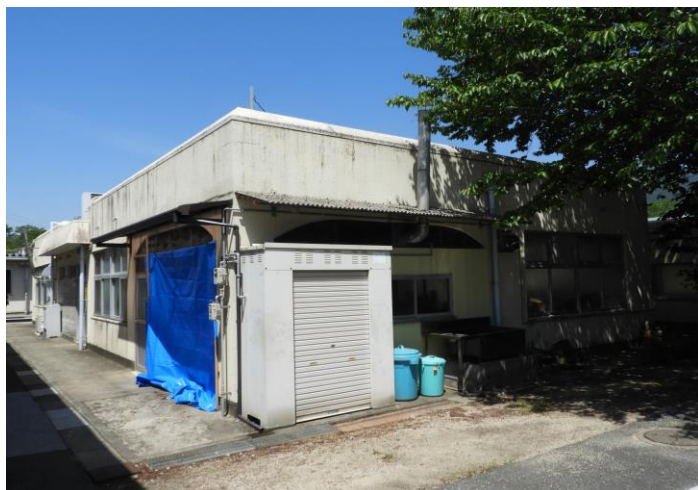
R3年度解体箇所(旧作業棟南側)
