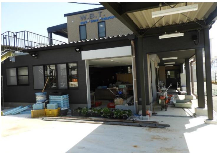
新作業棟1階(農園芸班作業場)
